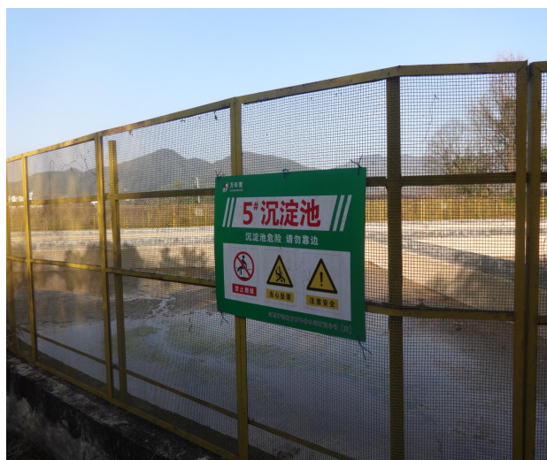
图 2-26 矿区北东侧沉砂池
