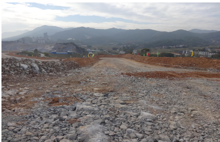
图 2-23 矿山运输道路
