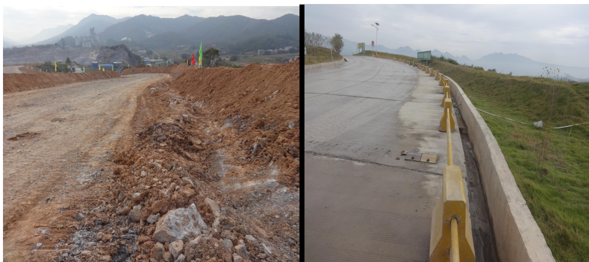
图 2-25 运输道路排水沟
