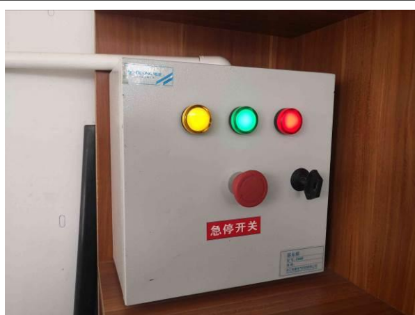
图 2-16 加油机紧急按钮
