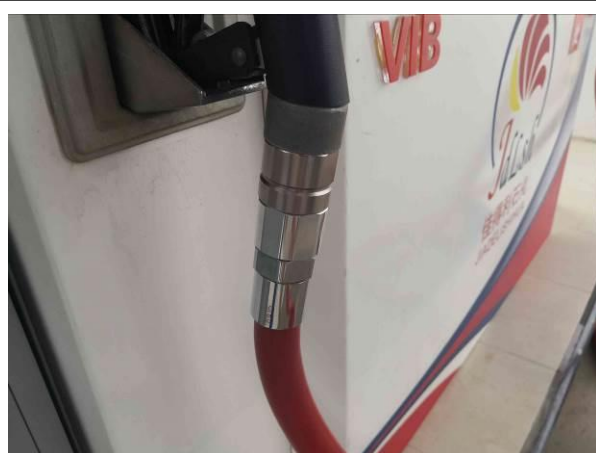
图 2-15 加油机拉断阀
