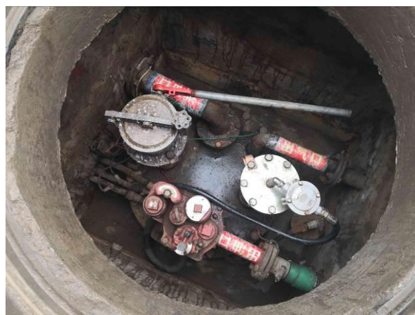
图 2-19 油罐人孔操作井
