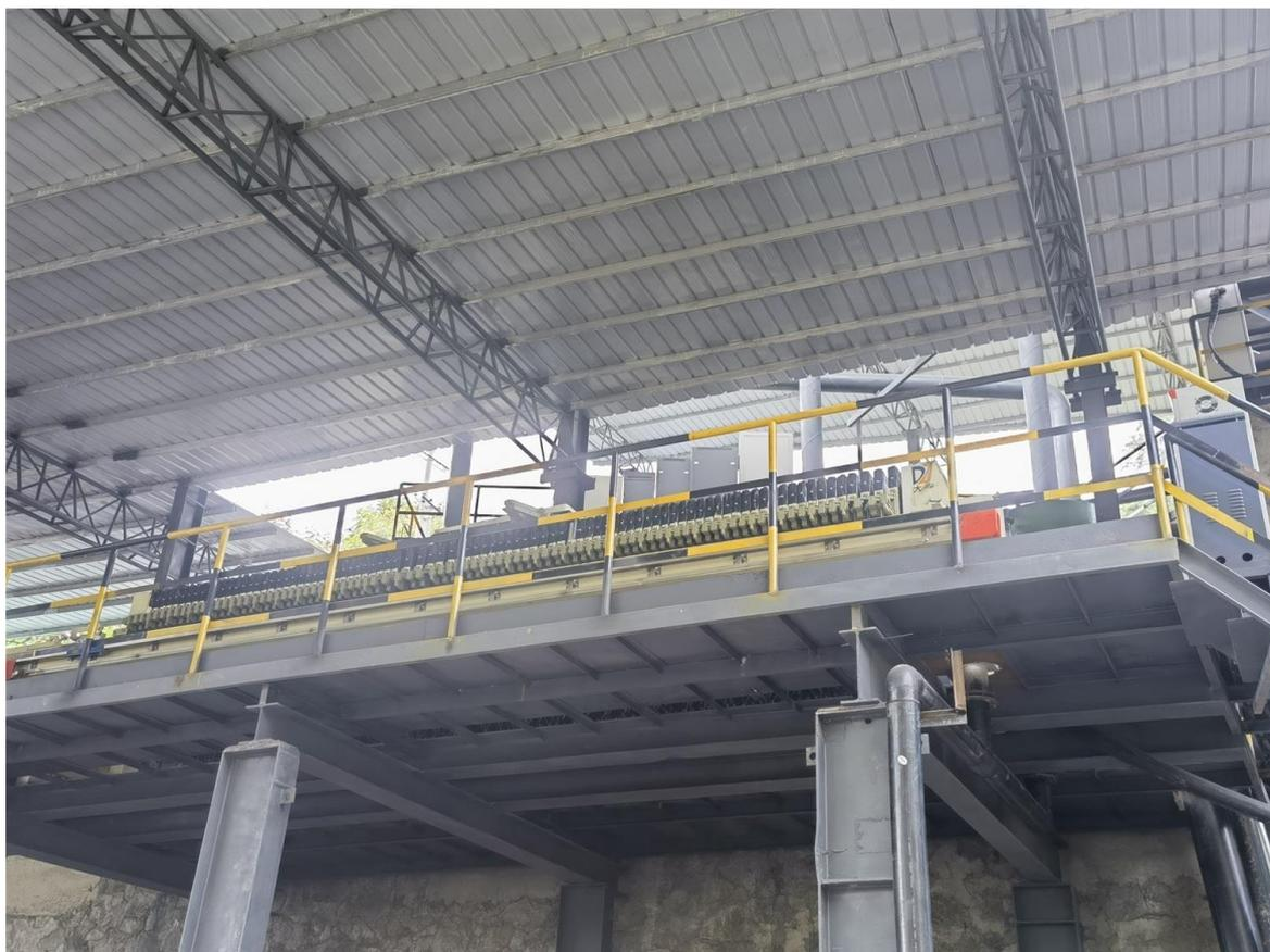
图 2.8-22 压滤机平台及安全防护栏
