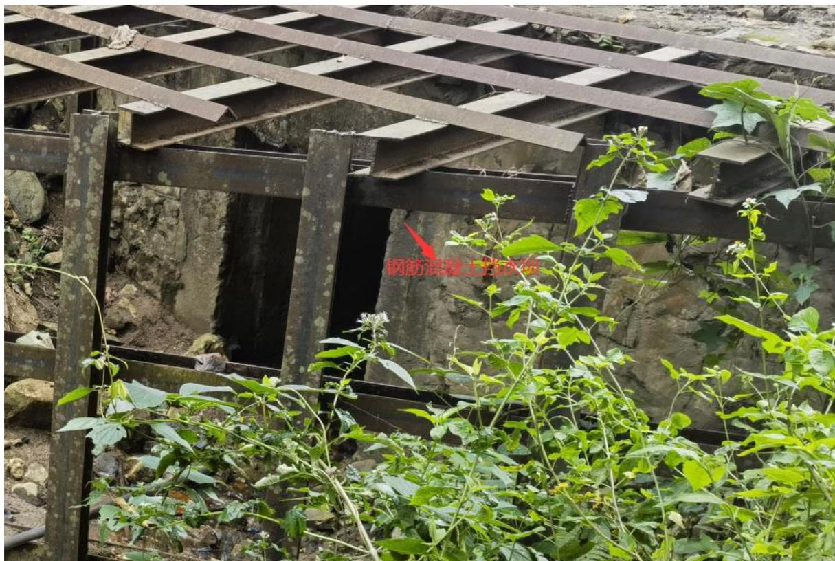
图 2.8-11 排水斜槽进水口处挡水坝 2
