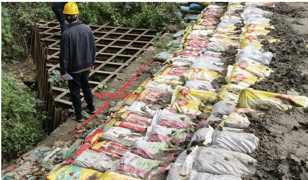
图 2.8-10 排水斜槽进水口处挡水坝及挡水坝前金属格栅
