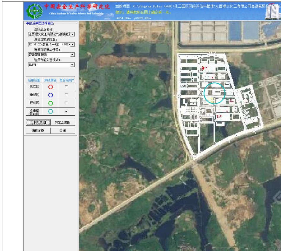
F152a 装置（一期）（702A）R152a 检测槽整体破裂发生 BLEVE
