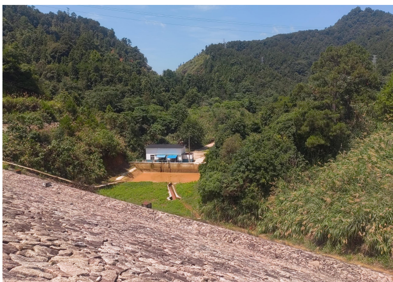
截渗坝和集水池
