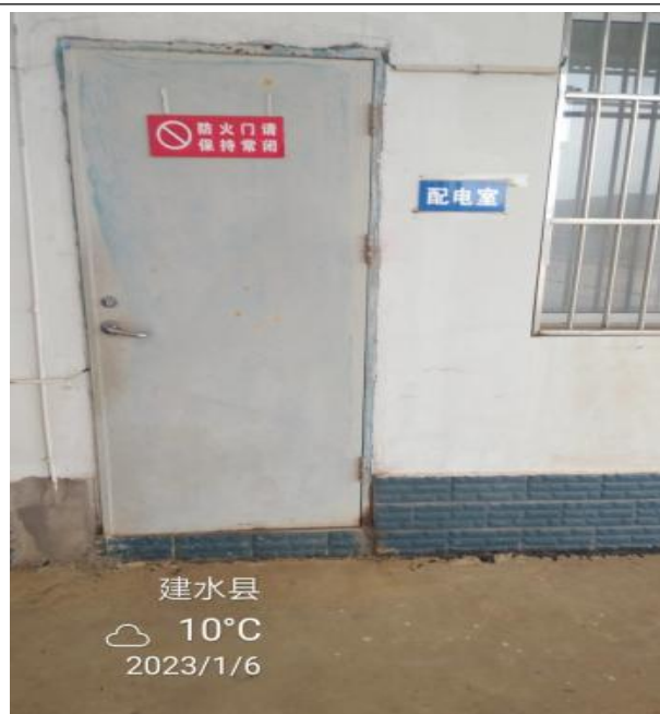
图 2-20 加油站配电室
