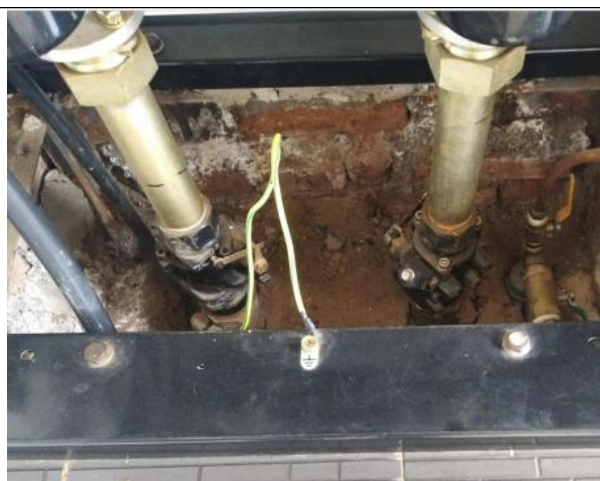
图 2-25 加油机紧急拉断阀
