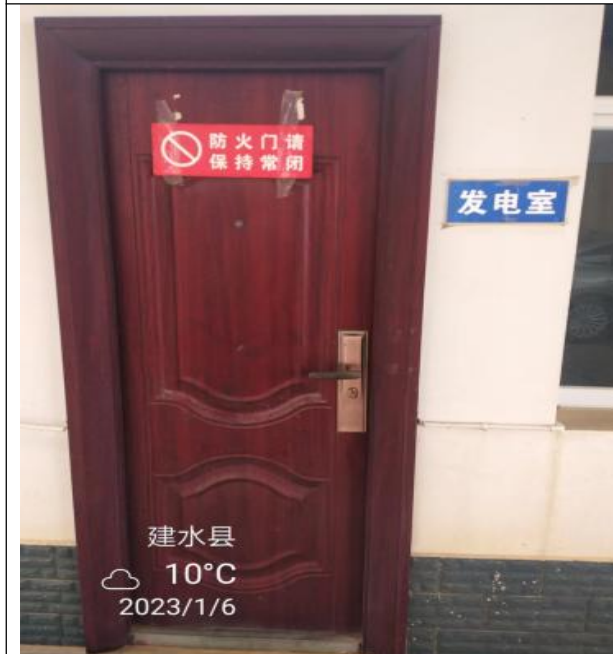
图 2-19 加油站发电机室
