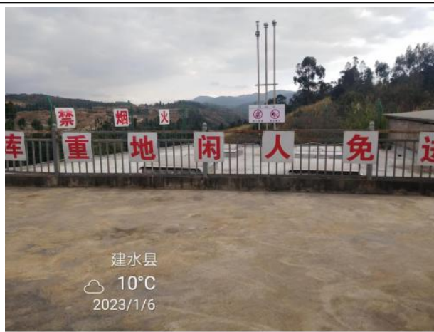
图 2-23 加油站储罐区
