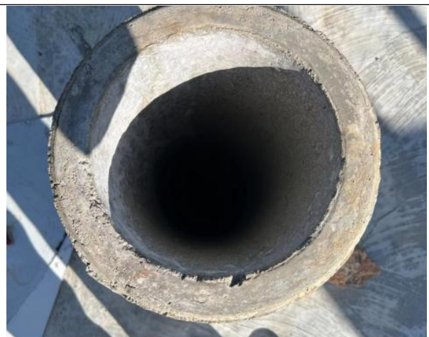
图 2-18 加油站罐区水位观测井
