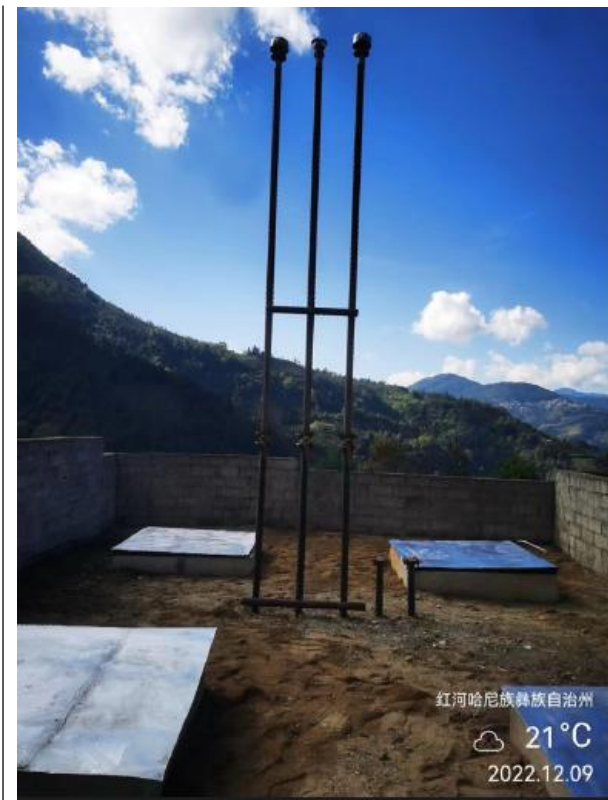
图 2-7 加油区（油罐区）
