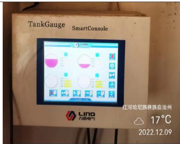
图 2-12 高液位监测报警仪
