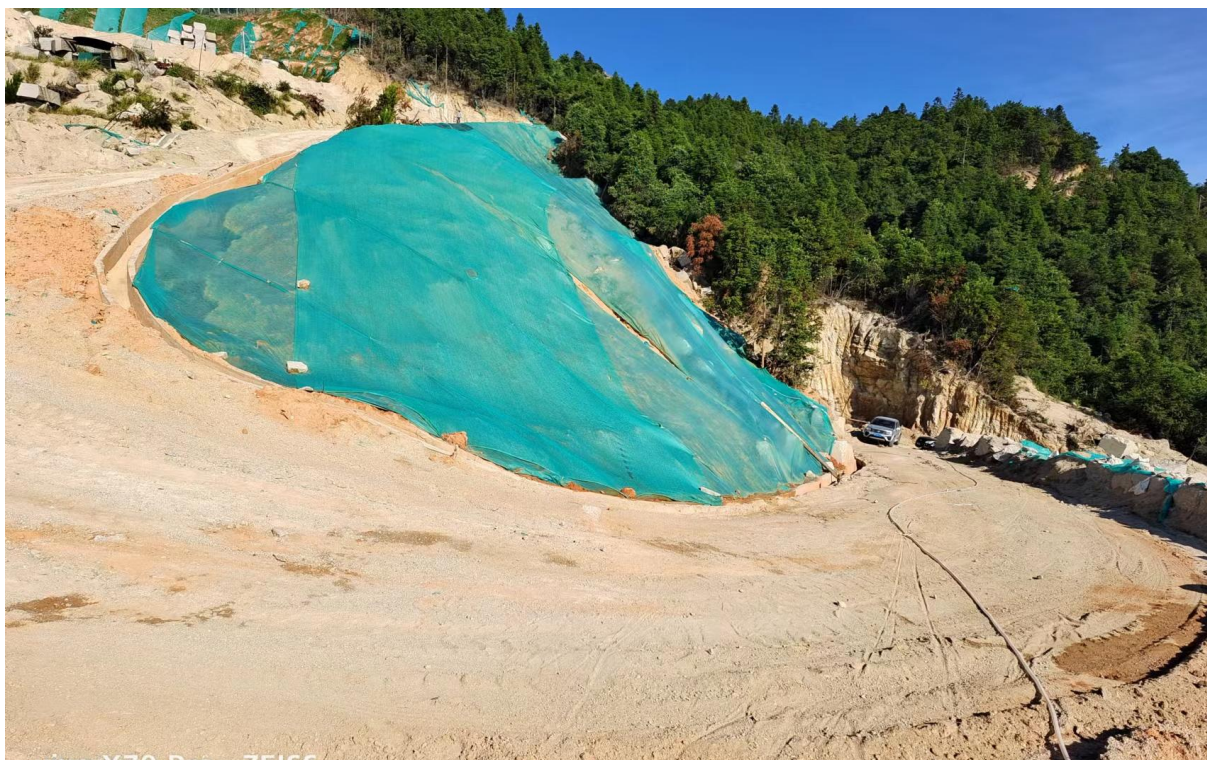
采场运输公路
